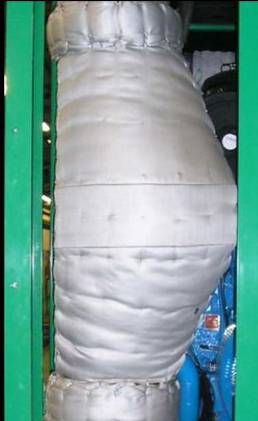
Moderne Umweltschutzaufgaben verlangen bei Dieselmotoren nach Partikelfiltern, auch Rußfilter oder Dieselpartikelfilter genannt. Zum eigentlichen Reinigungsprozess ist jedoch auch eine relativ hohe Temperatur erforderlich. Mit dieser über die Abgastemperatur zugeführten Wärmeenergie muss sparsam umgegangen werden, damit der Filter möglichst schnell seine Wirkung entfalten kann. Dazu wird sowohl die Abgasleitung als auch der Dieselpartikelfilter bzw. der Rußfilter isoliert.
